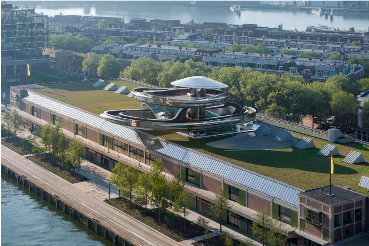
Die Treppe, intern als „Tornado“ bezeichnet, ist sowohl funktionales Erschließungselement als auch gestalterisches Leitmotiv. 336 Stufen führen auf eine Aussichtsplattform über der Maas. Außen reflektieren 297 individuell polierte Edelstahlpaneele Himmel und Stadt, innen erzeugen 12.500 verbaute **Kebony Clear-Dielen** eine warme, taktile Wirkung. Jedes verbaute Brett ist per QR-Code dokumentiert und zurückverfolgbar.
